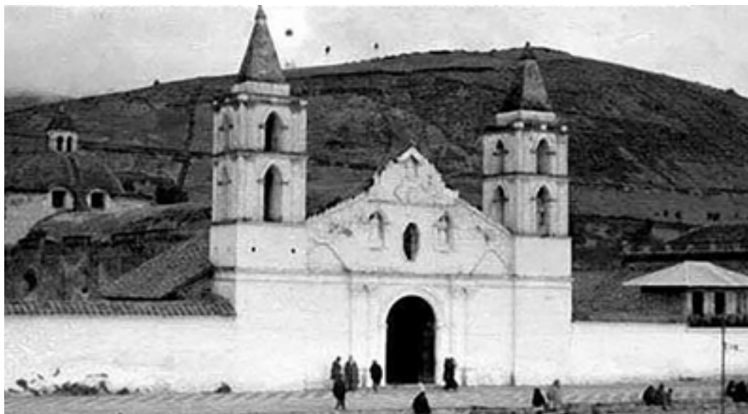
Iglesia Matriz construida con piedra pómez, cal y bóvedas, en tiempo de fray Tomas Duque, sobrino del Rey Fernando II de España foto Paredes, 1913
