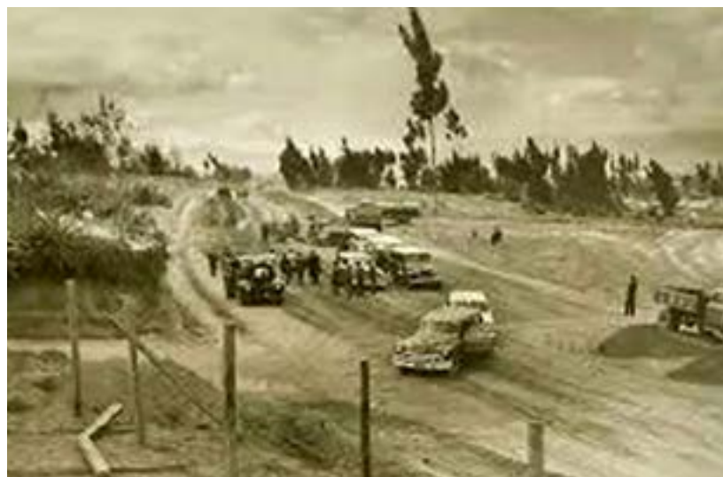
Construcción de la carretera Pujilí Quevedo 1942
